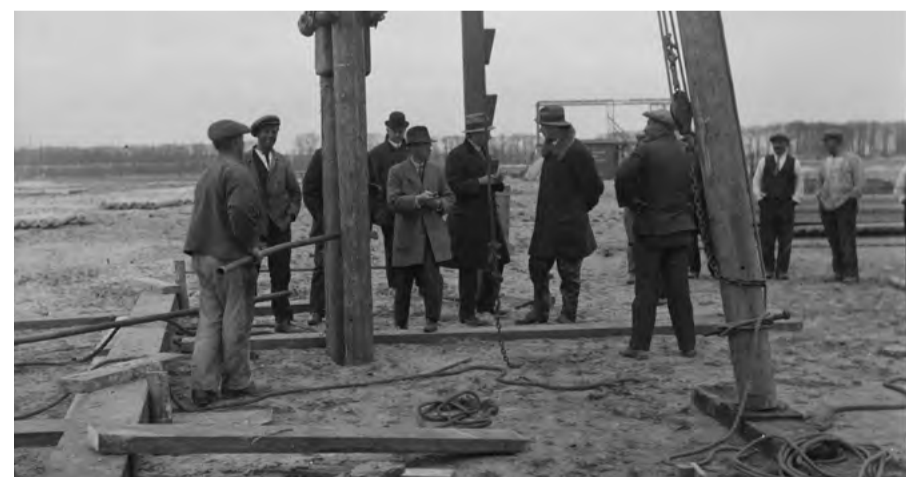
Betondorp in aanbouw
